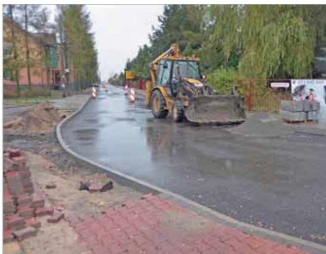
Trwają prace modernizacyjne przy ul. Poprzecznej w Borzęcinie Dużym.
